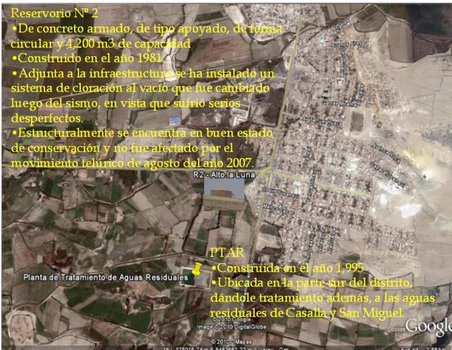
Imagen 5. Reservorio N° 2 y Planta de Tratamiento de Aguas Residuales
