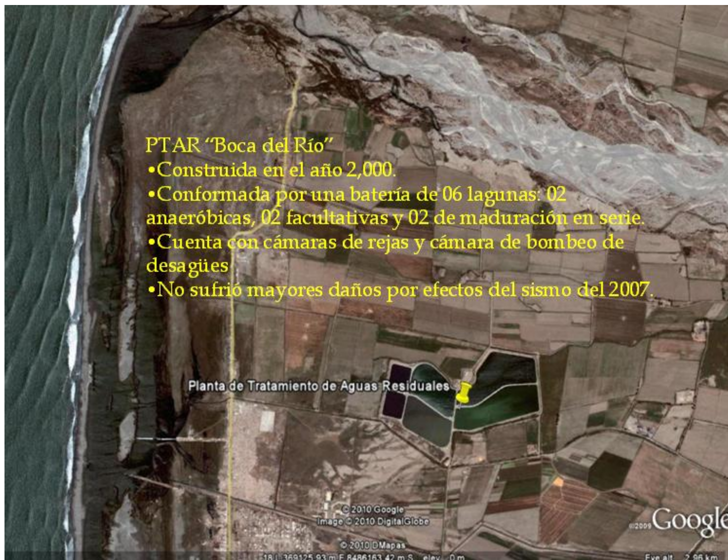
Imagen 7. Planta de Tratamiento de Aguas Residuales "Boca del Río"
