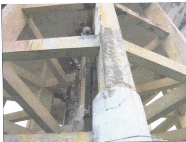
Figura 05: Reservorio Elevado N°1
